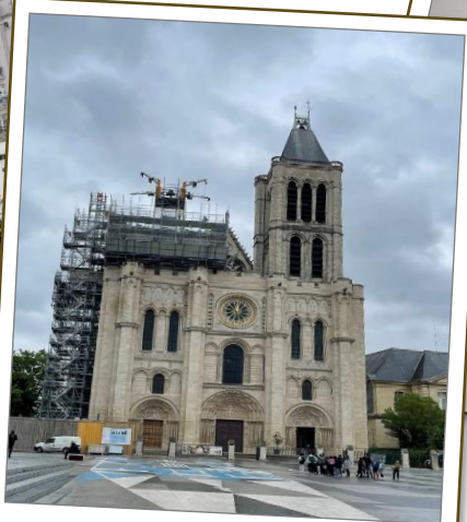
Construction de la flèche de la cathédrale de Saint-Denis
